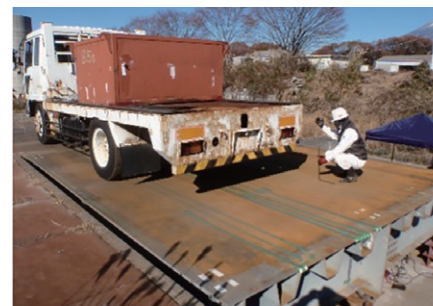
鋼床版の静的載荷試験
