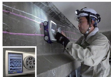
電磁波レーダによる鉄筋探査
