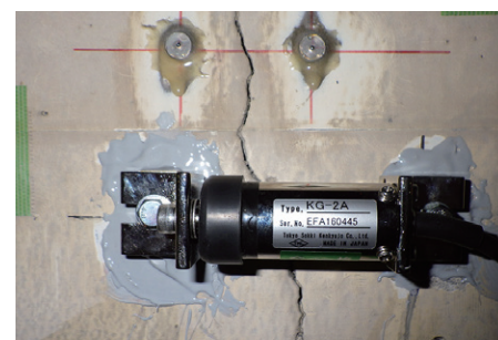
コンクリートひび割れ幅 変位計測
